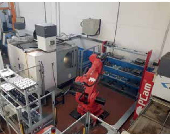
Sopra: la cella è stata installata in Meccanica Fabbri dalla Atlem Valtec, e funziona ormai da quasi due anni
